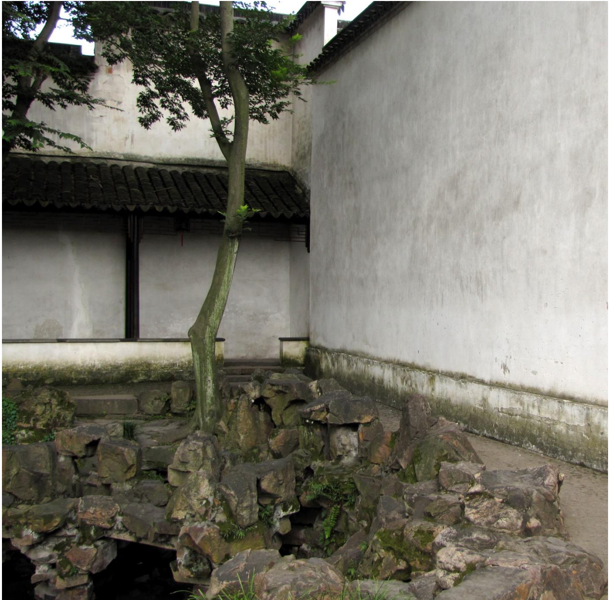
Fig. 214 L'extrémité sud de l'ancien Buyuan, la galerie couverte coupée par le grand mur, laquelle conduit originellement à la demeure , vue de 2010, cl. ibid.
