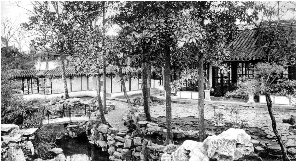
Fig. 138 La Salle aux Parfums lointains et la galerie couverte, vue prise de la rocaille vers le nord-ouest : « Le spectacle au sud de la Salle aux Parfums lointains », épreuve photographique, entre 1958 et 1964, cl. dans LIU Dunzhen, Suzhou gudian yuanlin ( Les jardins classiques de Suzhou ), Beijing (Pékin), Zhongguo jianzhu gongye chubanshe (China Architecture and Building Press), 1979, pl. I-28 (p. 322).
