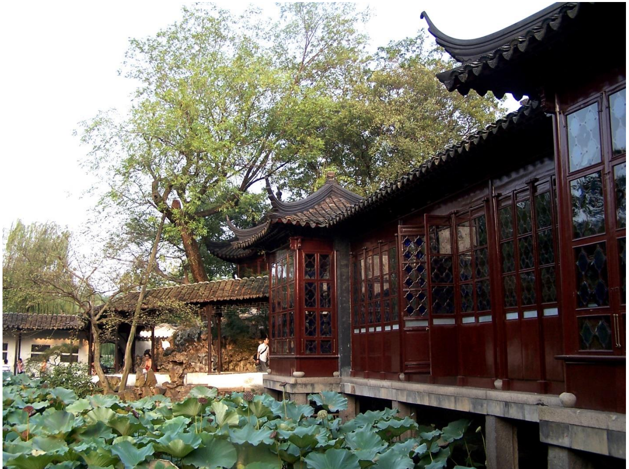
Fig. 189 Les Salons en paire des Trente-six Canards mandarins et des Dix-huit Camélias, façade sur la pièce d'eau, vue de 2005, cl. de l'auteur.
