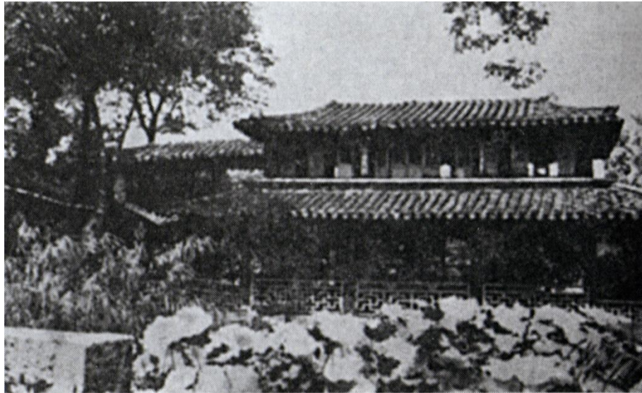
Fig. 227 La Maison à étage d'un Aperçu de la Montagne à la veille de la guerre sino-japonaise (1937-1945), avec les balustrades à motif en forme du « 卍 » au rez-de-chaussée et les fenêtres ordinaires au premier étage : « Zhuozhengyuan Suzhou », épreuve photographique, entre 1931 et 1937, cl. dans TONG Jun, Jiangnan yuanlin zhi ( Notice des jardins du Jiangnan ), Beijing (Pékin), Zhongguo gongye chubanshe (Éditions d'industrie de Chine), II ème édition, 1984, fig. 94 (p. 59).
