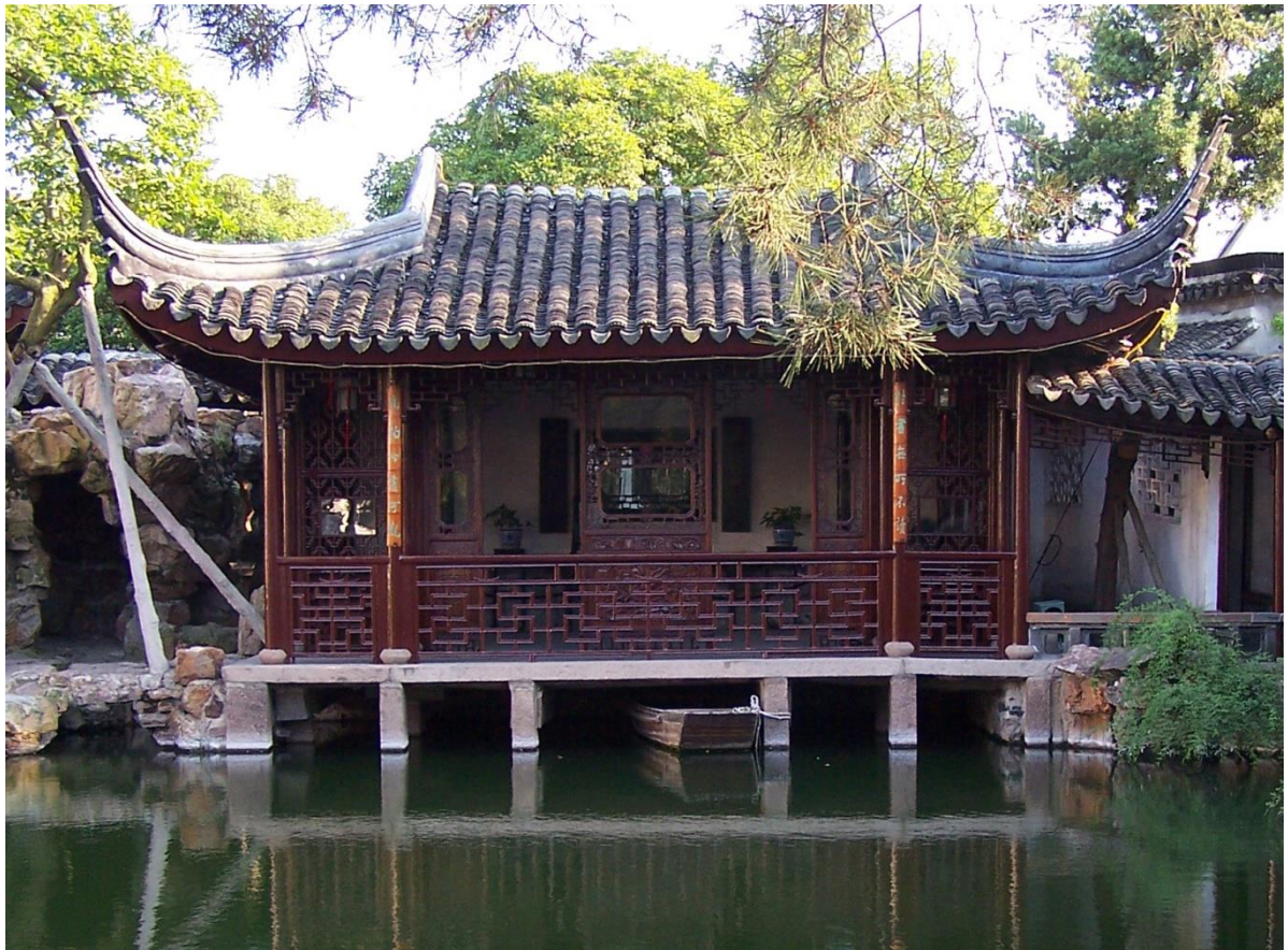
Fig. 303 Le Zhuo ying shui ge (濯纓水閣, Pavillon sur la pièce d'eau à Laver les Cordons de mon chapeau) du Wangshiyuan, vue de 2006, cl. ibid. Ce pavillon est décoré de treillis ciselés et de panneaux sculptés sur un thème théâtral.
