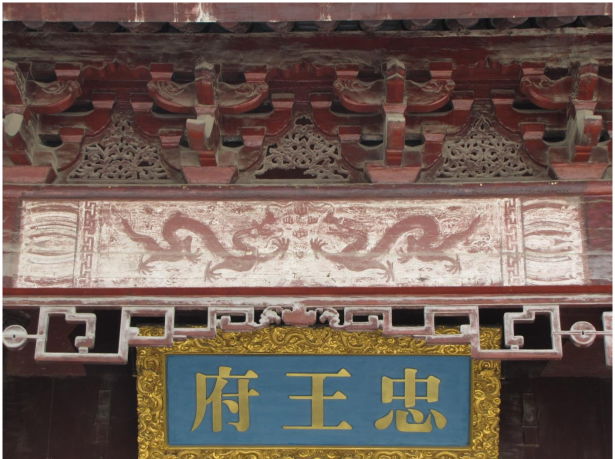
Fig. 118 La Salle d'entrée du Foyer, les consoles ornementales et les images de dragons peintes sur la face de la poutre, vue de 2010, cl. Li Chunhui.
