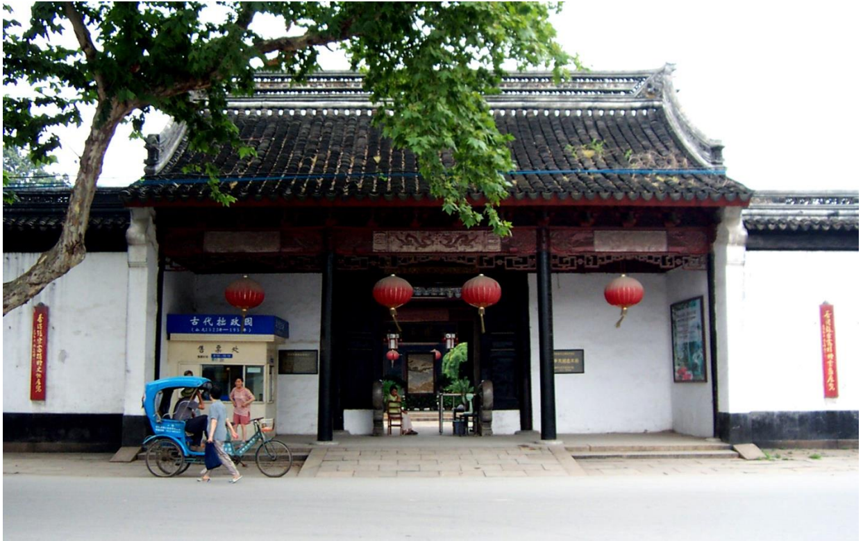
Fig. 117 La Salle d'entrée du Foyer, vue de 2003 prise de la Rue Nord de l'Est, cl. de l'auteur.
