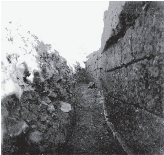
Fig. 11 - Trincea di scavo praticata da F. Ranaldi a ridosso delle mura di fortificazione della c.d. Acropoli (archivio del Museo Provinciale di Potenza).
